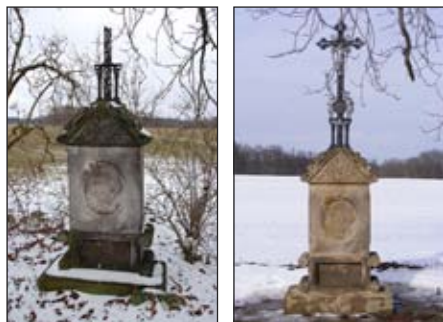
Kalovice původní stav Kalovice po opravě Kamenické práce: bohatě reliéfně zdobená boží muka, náročná restaurování především rozlomené hlavice Restaurování litinové části: demontáž kříže, kompletní vyčištění, odlítí chybějících částí a kompleta-ce kříže, kompletní konzervace, osazení
